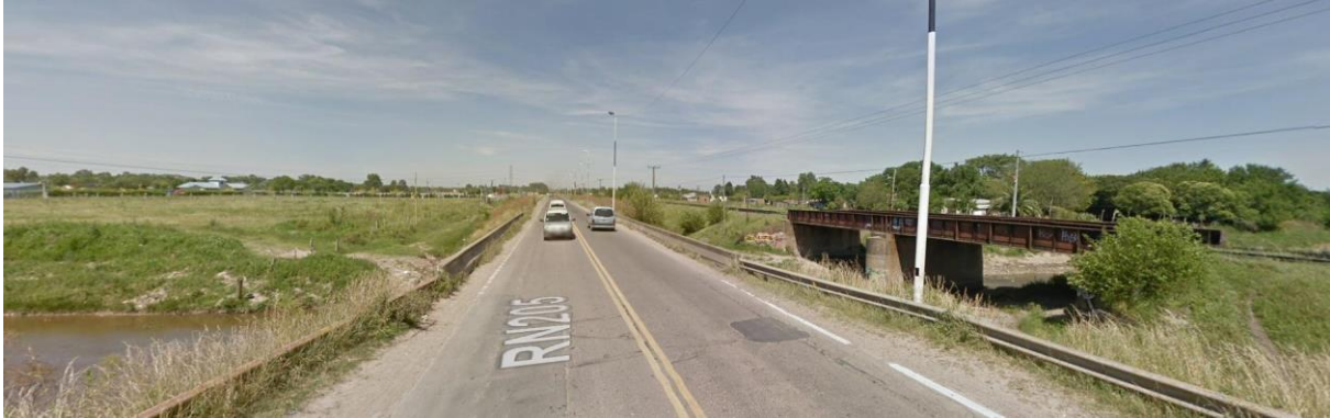
Imagen 4: Puente s/A° Del Gato (Prog. 0+000)
