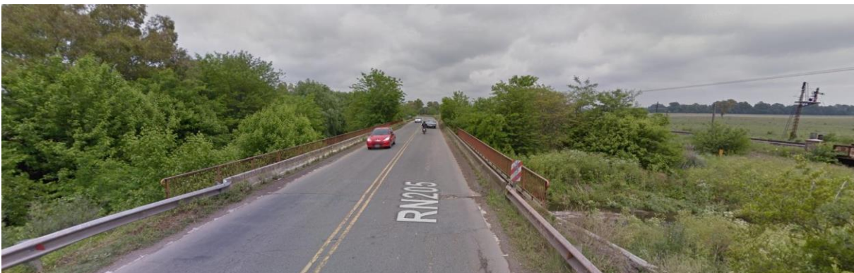
Imagen 5: Puente s/A° Cañuelas (Prog. 6+400)
