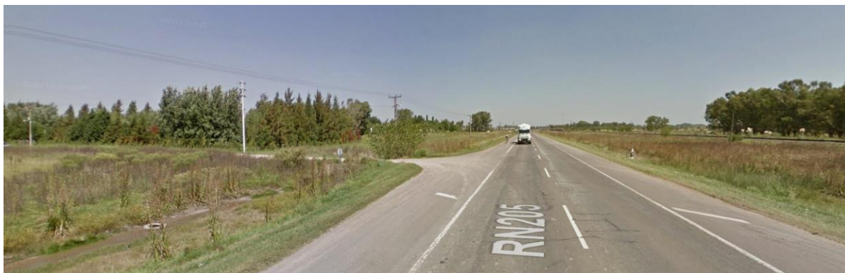
Imagen 7: Limpieza y desobstrucción de préstamos y alcantarillas laterales.
