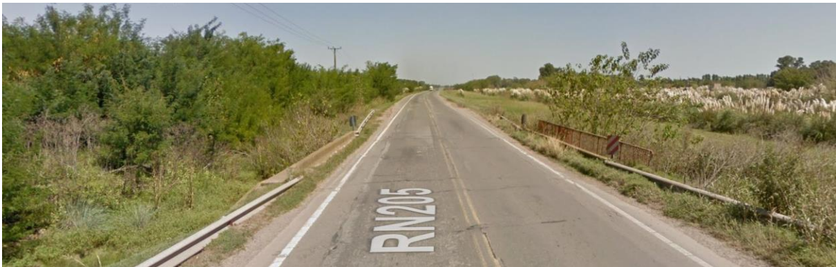
Imagen 6: Puente s/A° Cementerio (Prog. 12+180)
